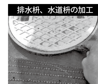
排水桝、水道桝の加工 マスの角部にチョークで粉をつけ、リアリーターフ®の上から軽く叩くと裏に墨がつきます。
