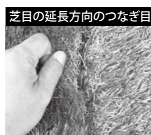
芝目の延長方向のつなぎ目 パイルの縫い目を合わせ、基盤シートを5mm以内に突き合わせ固定してください。
