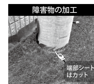
障害物の加工 柱等の構造物は縦・横の寸法を測ってバックングに墨付けし、カッターで切断します。
