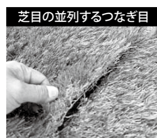
芝目の並列するつなぎ目 パイル高さ 25mm・40mmの隙間は10mm以内で固定してください。
