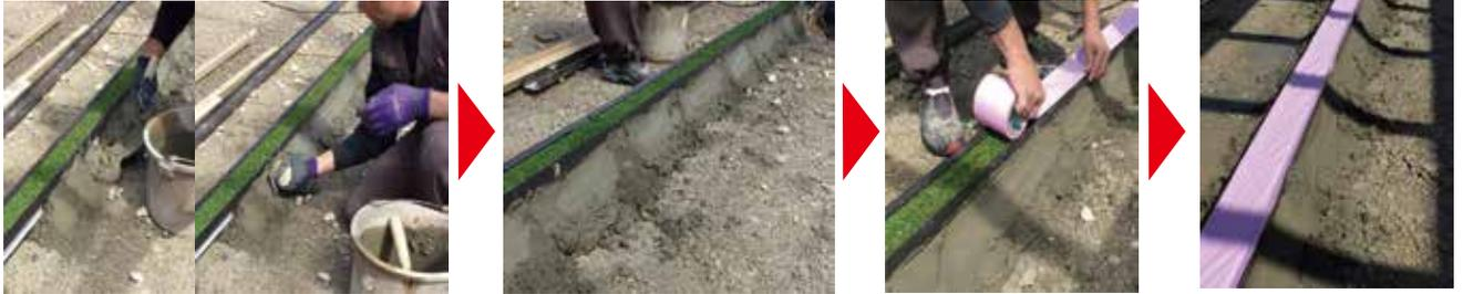
④ベース材へモルタルを擦り付け、固定する
