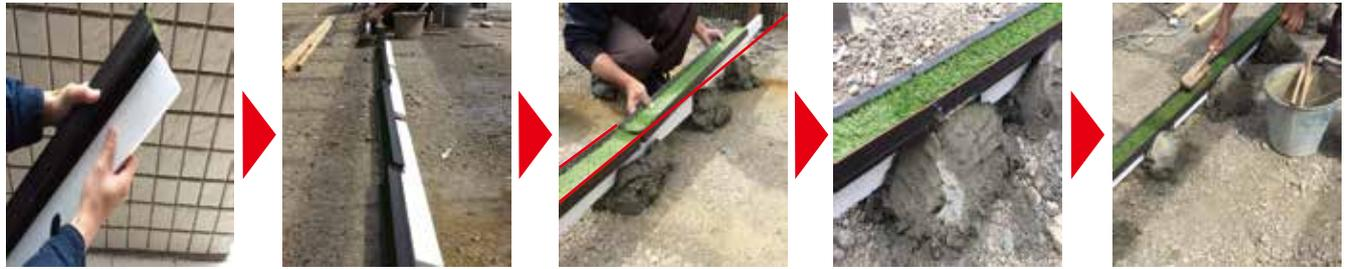
①ベース材のはめ込み ②モルタルを敷きベース材を固定し、水系に合わせて勾配や傾きを調整する ③汚れの清掃
