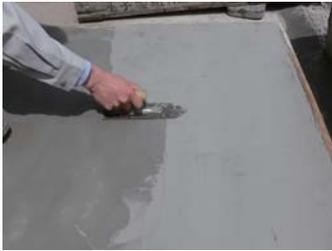
モルタル・コンクリート下地に適度な水湿しをしてから下塗材を約1mmの厚さでコテ塗ります。
