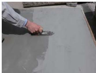
モルタル・コンクリート下地に適度な水湿しをしてから下塗材を約1mmの厚さでコテ塗りします。
