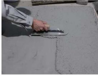
上塗材を定規などをを使用して規定厚に塗付けてください。
