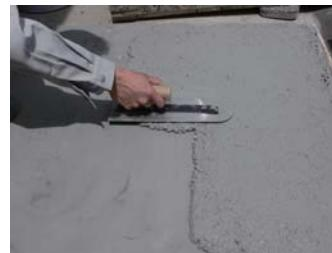
上塗材を定規などを使用して規定厚に塗付けてください。
