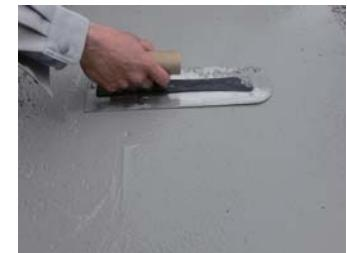
必ず水打ちをして仕上コテでアマを浮かしながら、巣穴が無いように均します。
