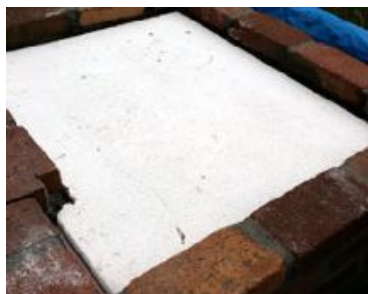
⑪屋根部材載せ
