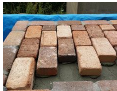
⑫屋根仕上げ
