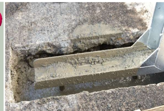
●ロックボルト(パワースレッド)と専用ナットが 固定されている事を確認
