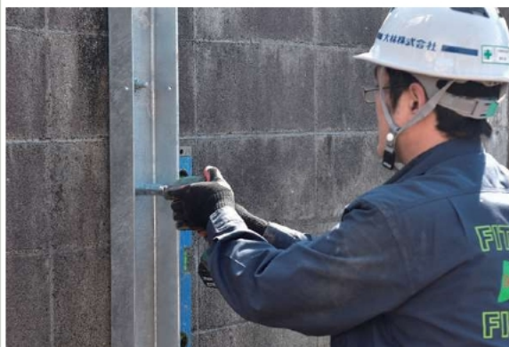
●敷地側アングル支柱をセット 角根丸頭ボルトを敷地側から締め付けて固定
