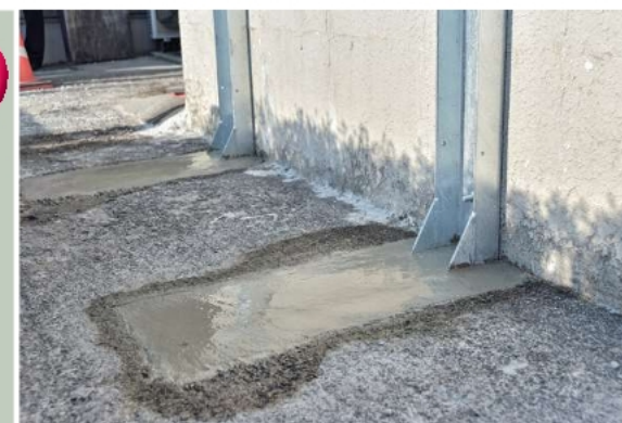
●敷地側完成 写真 FITパワー 18型アングル支柱
