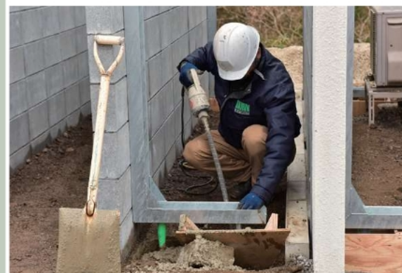
●パイプレータ等で空洞を無くす
