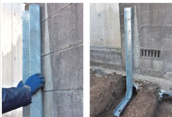
●敷地側アングル支柱の仮置き
